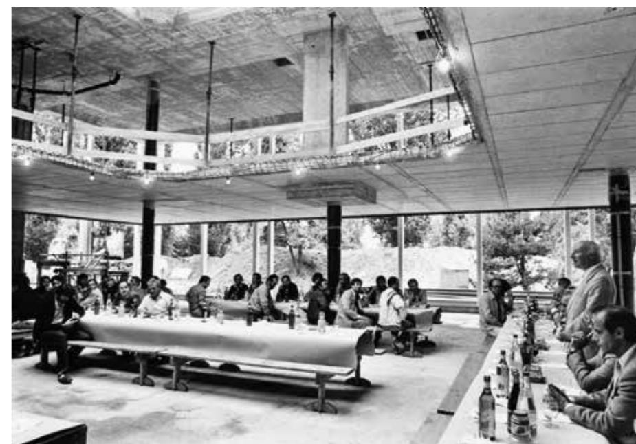
Trabajos de ampliación de la sede del COI en 1985. © Comité Olímpico Internacional 2014 - todos los derechos reservados
